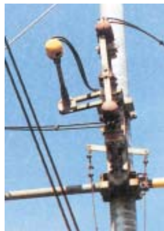
Figura 8: Commutatore in posizione di chiuso
